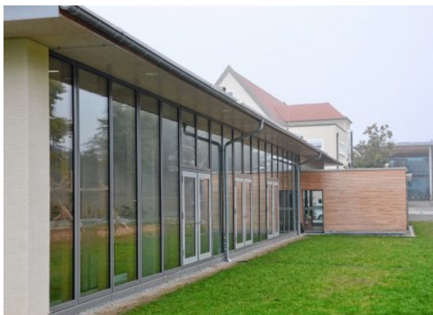
In der jüngst fertig gestellten Sportanlage bei der Jakob-Gretser-Grundschule ist es zu einem Wasserschaden gekommen. Der Grund: fehlerhafte Bauausführung. BILD: JÖRG BÜSCHE
